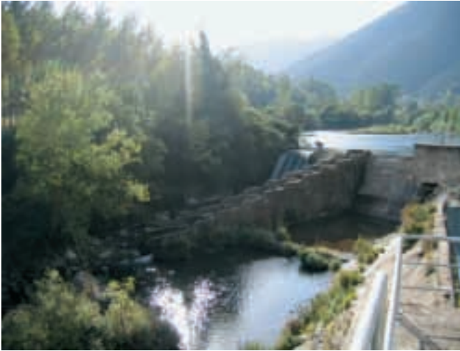
Mantenimiento y construcción de escalas
