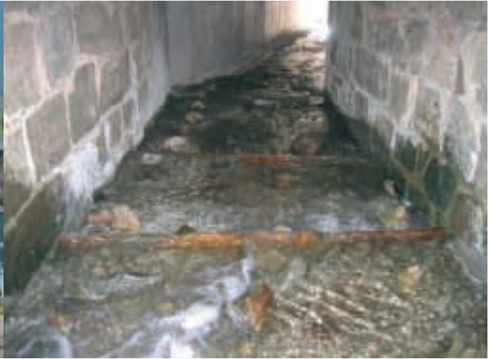
Adecuación de paso bajo carretera
