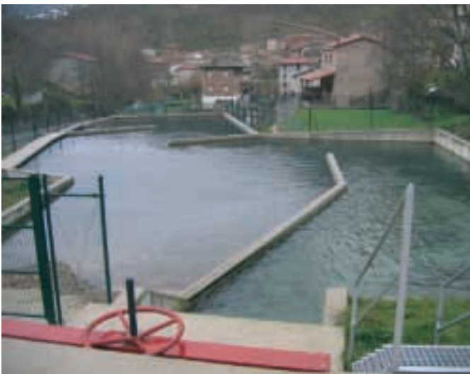
Balsa de decantación
