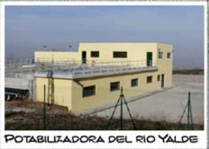
POTABILIZADORA DEL RIO YALDE
