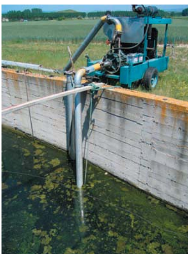
Captación de agua del acuífero
