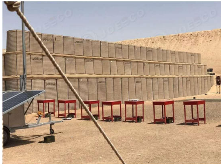
Foto 7.- Ejemplo de cancha de tiro ejecutada mediante gaviones flexibles
