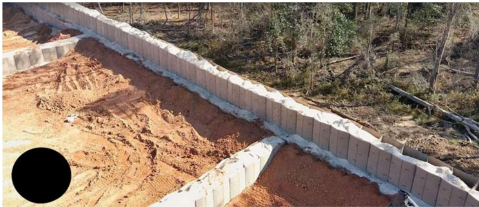
Foto 8.- Ejemplo de campo de tiro ejecutado mediante gaviones flexibles, en construcción.
