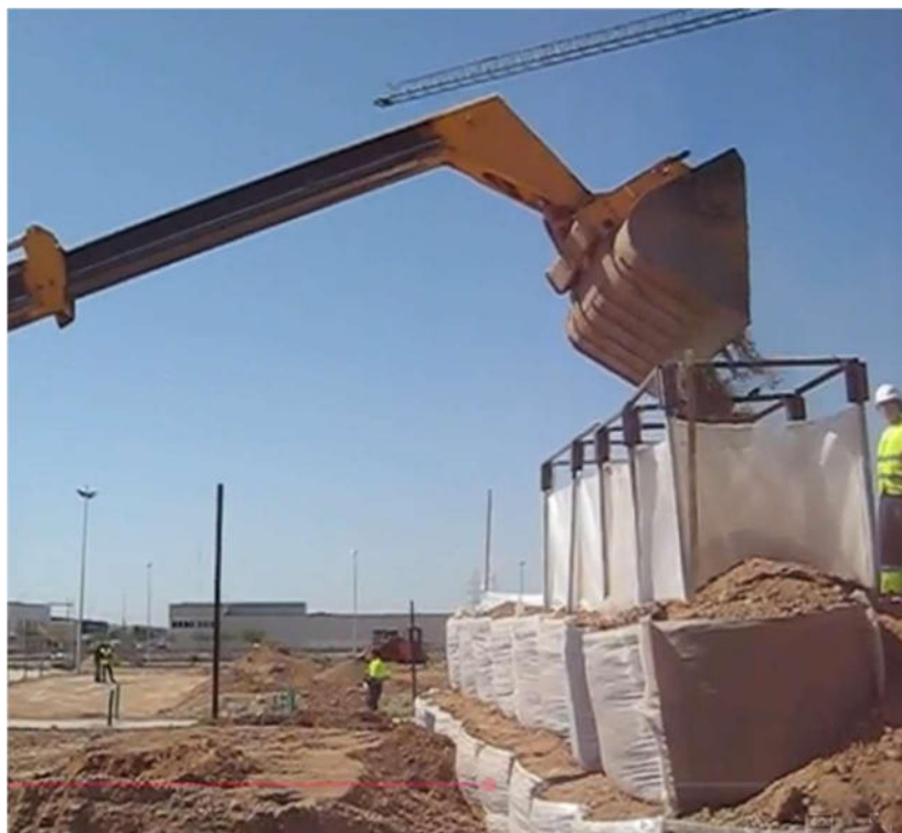
Foto 6.- Ejemplo de caballón ejecutado mediante gaviones textiles
