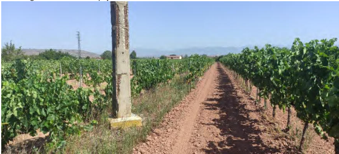
Fotografía 2. Estado del viñedo en el que se emplaza el apoyo nº 276.
