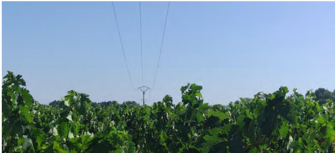
Fotografía 4. Conductores entre los apoyos nº 276 y nº 275.
