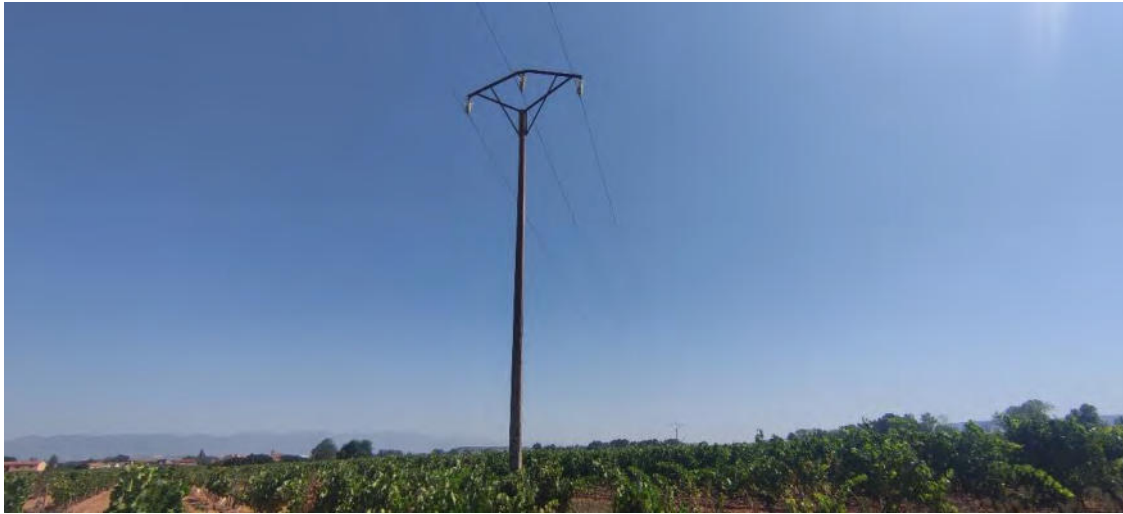
Fotografía 1. Detalle del apoyo nº 276 a sustituir.
