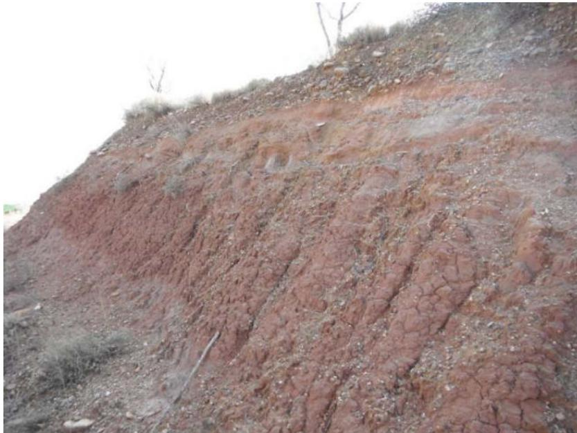
Imagen 11: Vista del perfil de un talud próximo a la zona a explotar. Se observa que en la zona superficial aparece el recubrimiento cuaternario y que apenas se diferencia de la tierra vegetal. A efectos prácticos es imposible de ejecutar la separación diferenciada de la tierra vegetal y del cuaternario.
