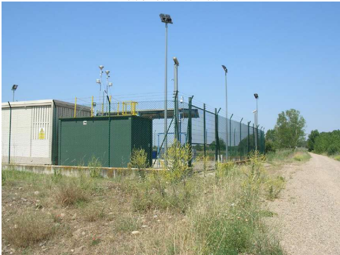
Foto 3. Estación de Arrúbal
