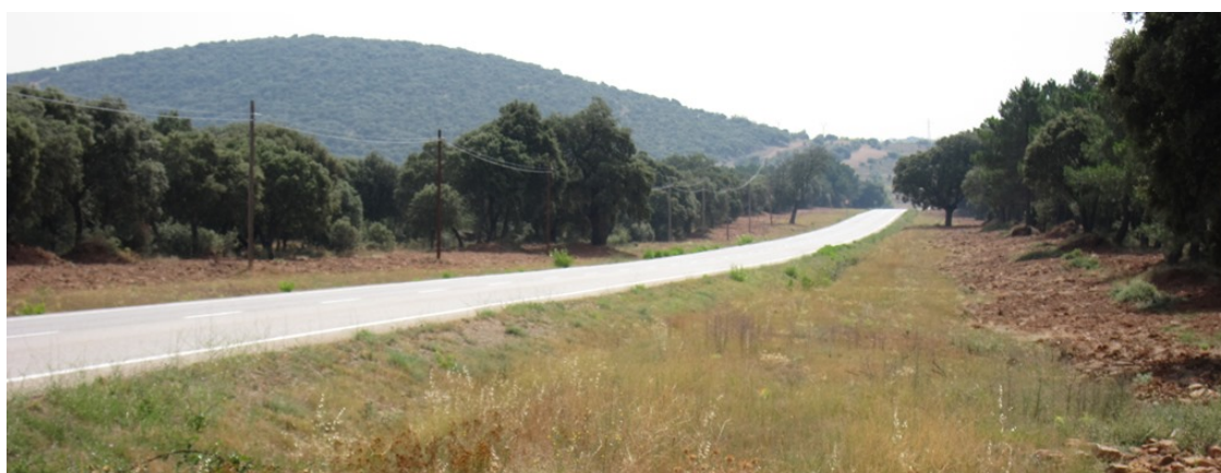
Foto 12: Carretera LR-123 a través del carrascal con una faja auxiliar sin vegetación.
