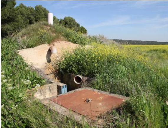
Foto 3: Toma de agua en la acequia del Cidacos para la conducción a la balsa L4.
