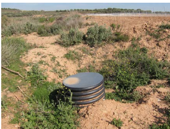
Foto 7: Toma de agua de la acequia soterrada que abastece al pantano de El Recuenco.
