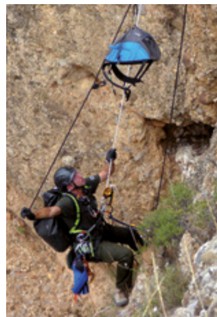
Mediante poleas se acercan el material hasta el lugar de trabajo.
