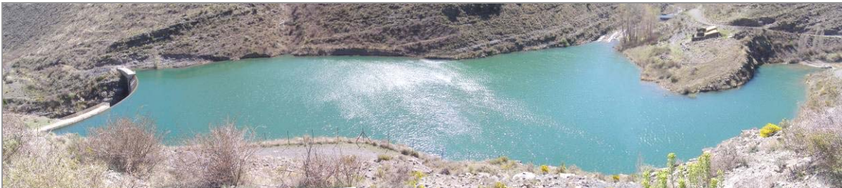
Presa de Cornago. Con 0,12 hm3 de capacidad abastece de agua de boca y riego a Cornago
