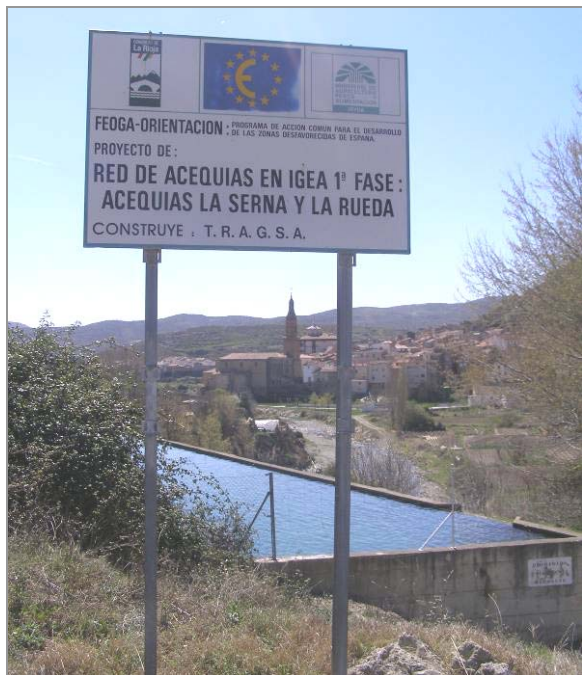
Panel informativo del FEOGA (programa de ayudas de la C.E.) y balsa de regulación interna de la Comunidad de Regantes de Igea
