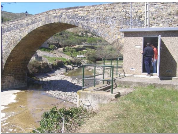
Estación de aforo 139 río Linares en Igea
