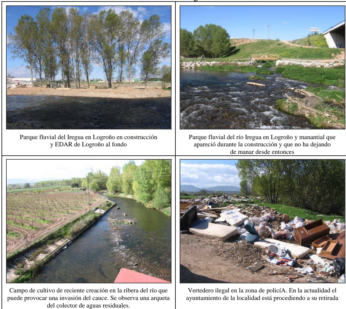
Figura 3.11: Principales problemas del tramo bajo del río Iregua desde el azud de Islallana hasta desembocadura. Fotografías tomadas el 5/4/2006.
