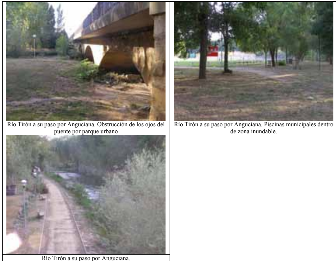
Figura 3.37: Fotos representativas de las características y problemas Río Tirón desde el río Oja hasta el río Ea. (265)
