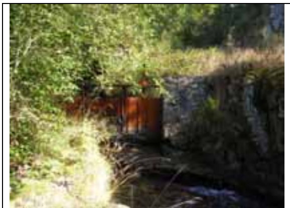
Canal de derivación para la central hidroeléctrica de Posadas
