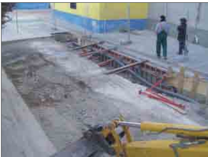
Obras de reparación de los daños producidos por la sima formada hace dos meses en el casco urbano de Alcalá de Ebro.
