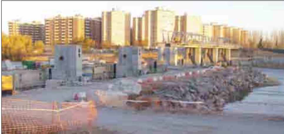
Obras del azud del Ebro en Zaragoza
