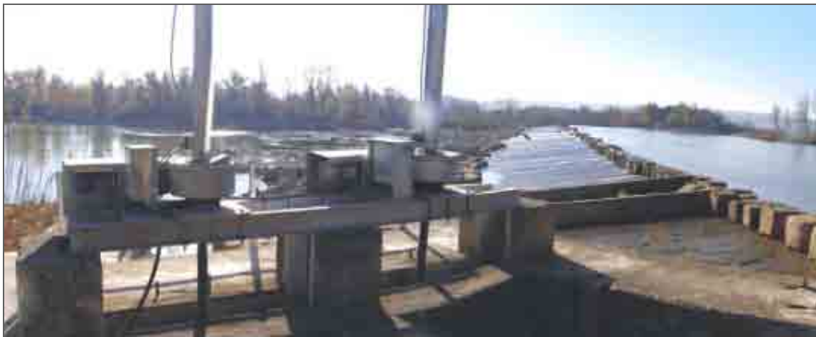
Vista del Ebro desde la CH de Pina (m.i.). Esta central tiene dos turbinas de 100 \text{ m}^3/\text{s} cada una y un salto de 4 m.
