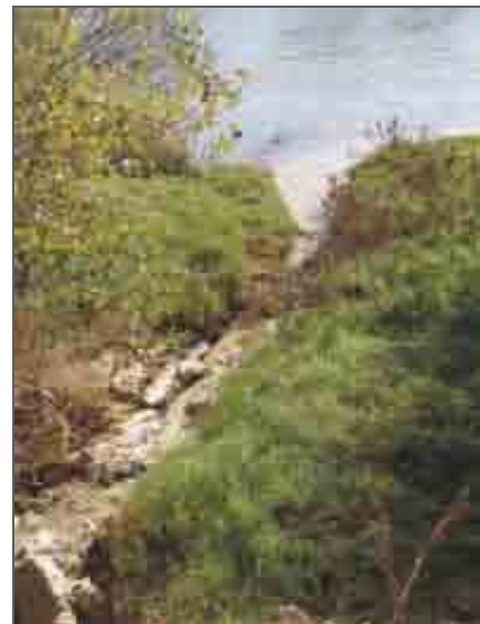
Punto de vertido de Remolinos, sin tratamiento.
