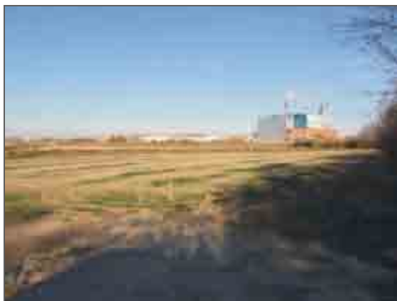
EDAR de La Cartuja, trata las aguas residuales de Zaragoza, en corto plazo tratara las aguas negras de Pastriz y La Puebla de Alfindén
