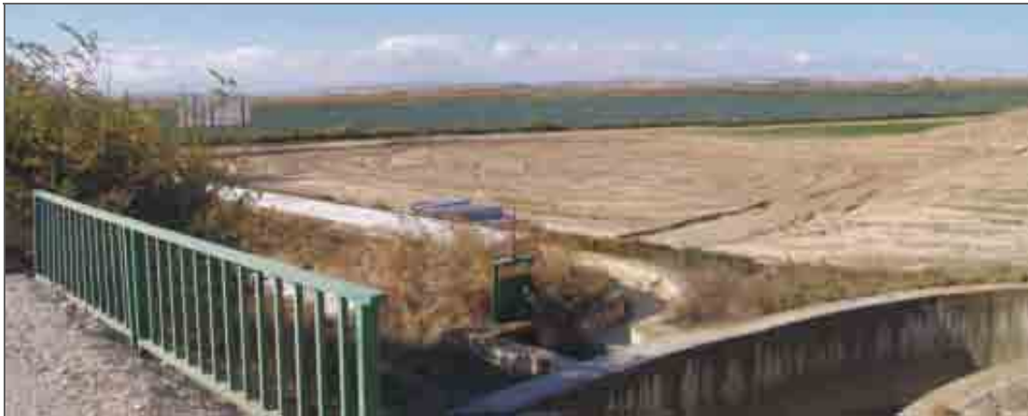
Construcción de la EDAR de Pradilla de Ebro, al estar localizada en zona inundable fue necesario elevar el terreno para salvaguardarla de las riadas.
