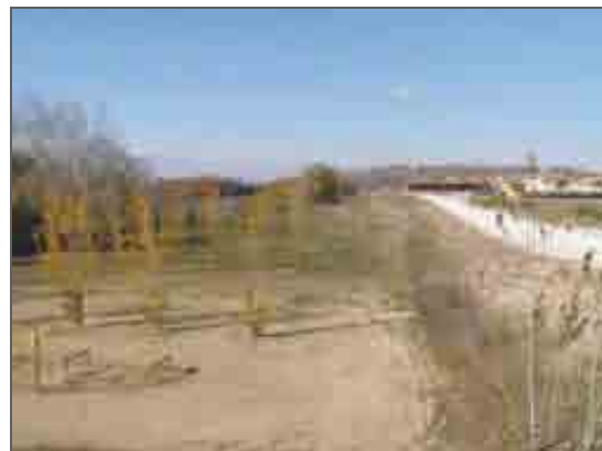
Carretera Pradilla de Ebro – Boquiñeni. Ha sido construida por AquaEbro. Esta carretera actuará como mota de protección de Padilla.
