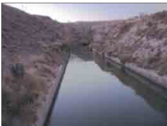
Salida del túnel de derivación a la CH Sástago II
