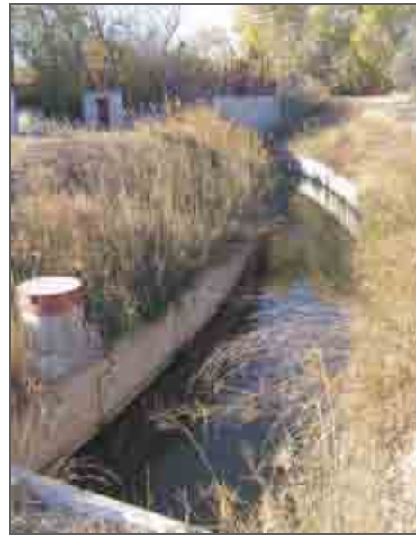
Acequia de Pina sobre la margen izquierda del río Ebro, toma sus aguas del azud de la presa del mismo nombre. En primer término de la foto se puede observar un limnígrafo.
