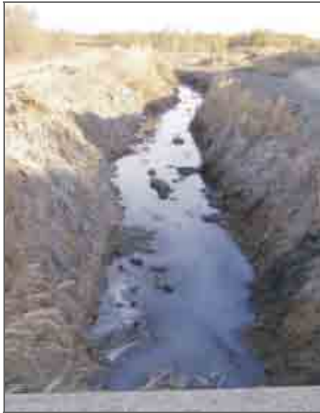
Canal de conducción de las aguas residuales de El Burgo de Ebro y su zona industrial, actualmente sin tratamiento.
