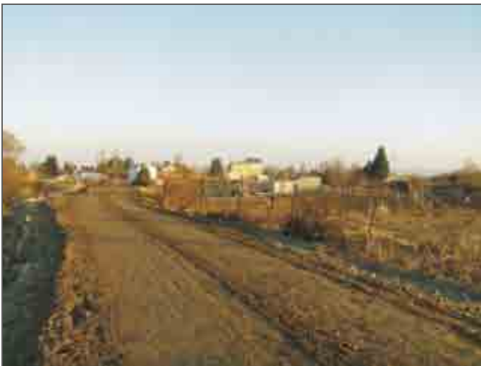
Urbanización Torre de Urzaiz en Pastriz. Presenta problemas de inundación en avenidas ordinarias. El agua comienza a meterse en la urbanización por el colector de Malpica-EDAR Cartuja.
