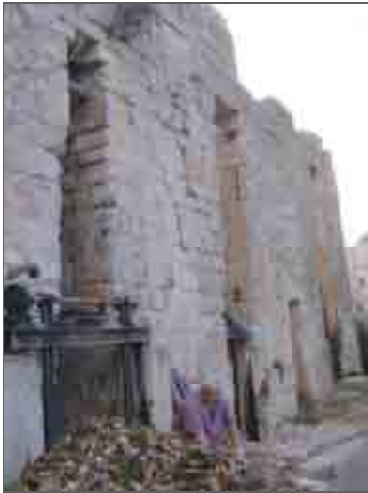
Caja de norias de la Casa del Molino, esta estructura data del siglo XVI, evidencia de los sistemas de aprovechamiento hidráulico en la ribera baja del Ebro
