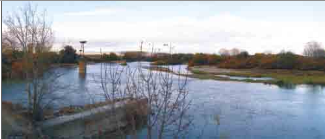
Río Ebro desde Alcalá de Ebro. El río se ha desplazado hacia esta localidad y por ello se han instalado espigones y escolleras de protección. Actualmente se está planteando la posibilidad de hacer canales de aguas altas para mejorar la protección en este tipo de puntos.
