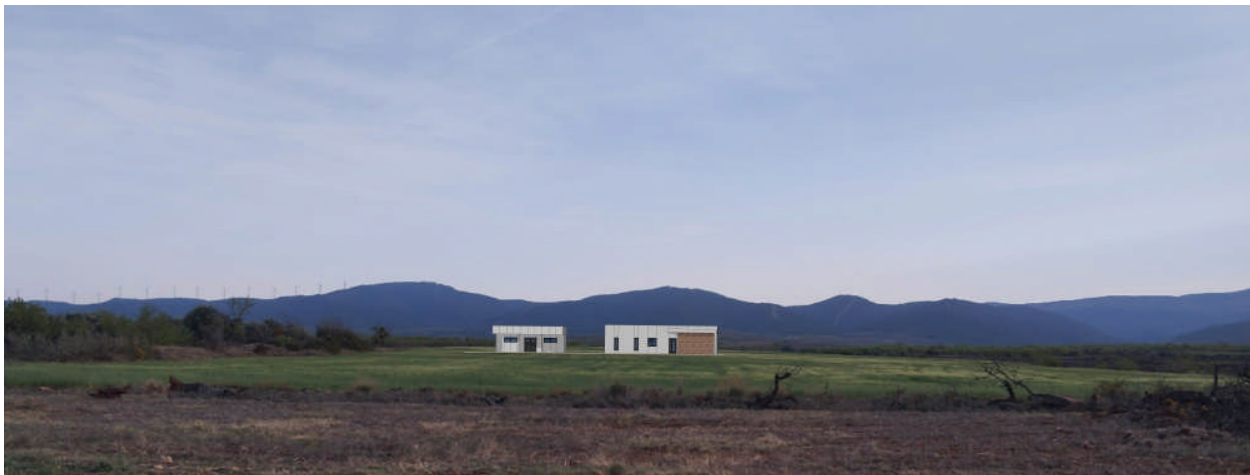
FOTOGRAFÍA DE LA PARCELA CON EDIFICIO
