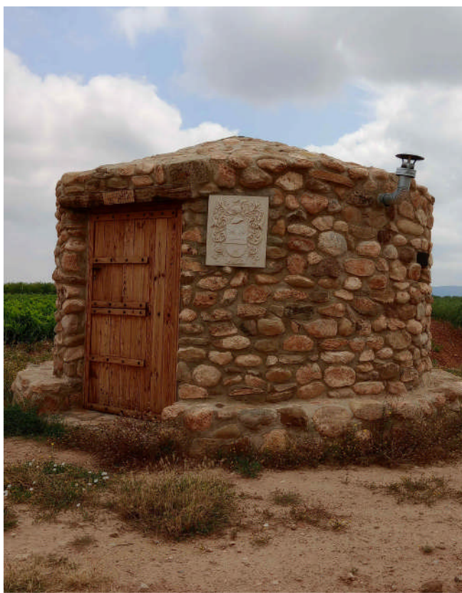
EDIFICIO EXISTENTE MAS CERCANO A LA PARCELA
