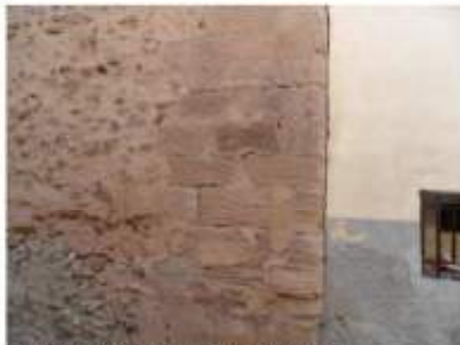
Detalle fábrica de sillera y mampostería
