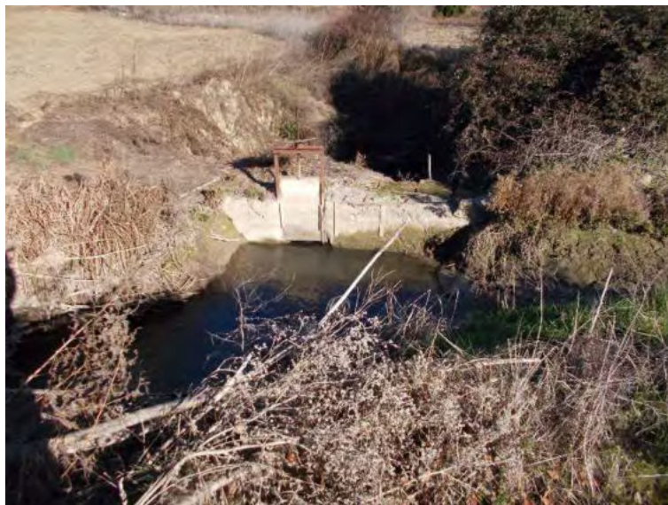
Foto 12 Derivación para el canal de la margen derecha del arroyo Zamaca, que alimentaría los molinos de Santa Lucía y San Andrés.
