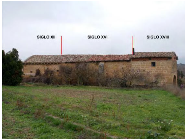
Foto 47 Ermita de Santa Lucía. Vista desde el sur, en la que se señala la extensión de las tres etapas constructivas principales.
