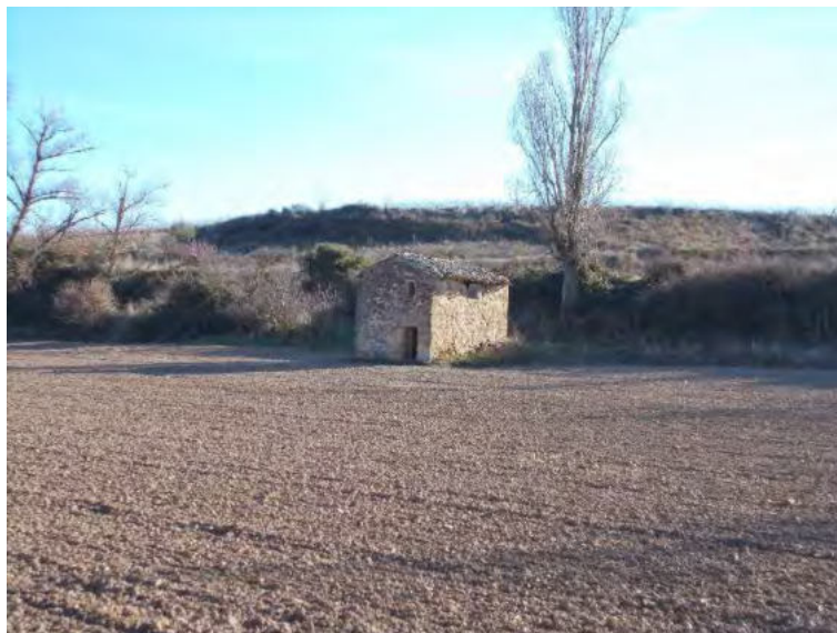
Foto 14 Caseta de mampostería con dos pisos de altura, ubicada en la parcela 3/550, situada en la margen derecha del arroyo Zamaca.
