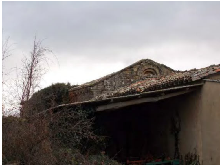
Foto 50 Ermita de Santa Lucía. Detalle del muro occidental que contaba con una ventana rematada con arco de medio punto moldurado.
