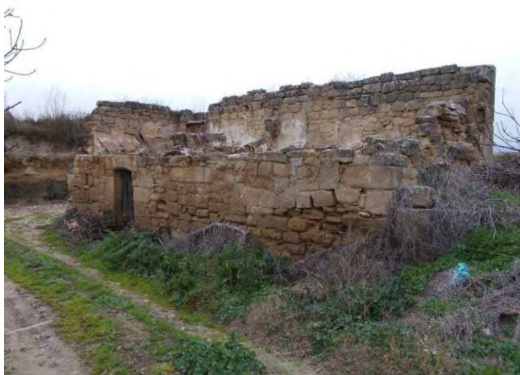
Foto 33 Restos de la ermita de San Millán vistos desde el sureste.
