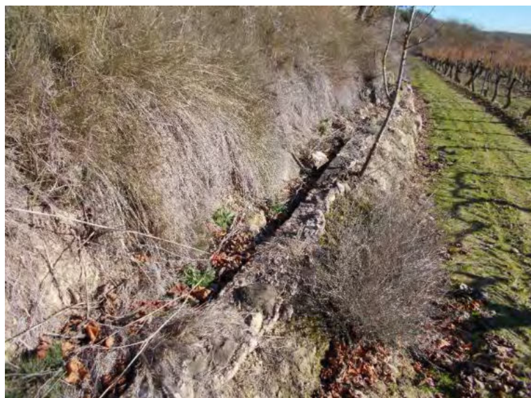
Foto 21 Atarjea de riego amortizada, localizada en el fondo de la vaguada de El Palomar.
