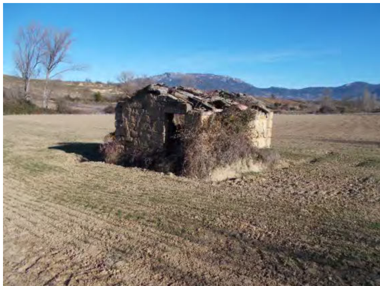
Foto 13 Chozo de mampostería que se conserva dentro de una parcela situada en la margen derecha del arroyo Zamaca.
