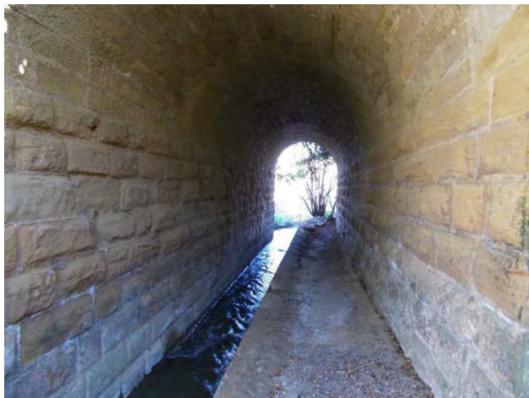
Foto 2 Puente del ferrocarril construido para dar salida al arroyo Zamaca.
