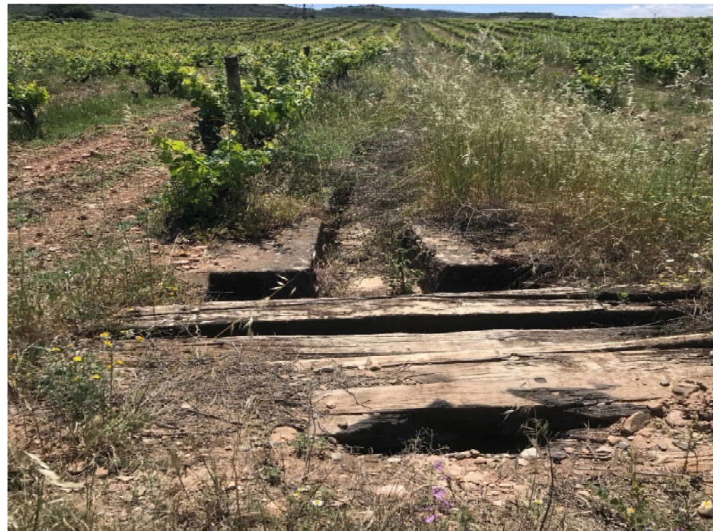
Foto 5. Acequia de hormigón. Infraestructura presente en la ubicación de la balsa a pie de canal.
