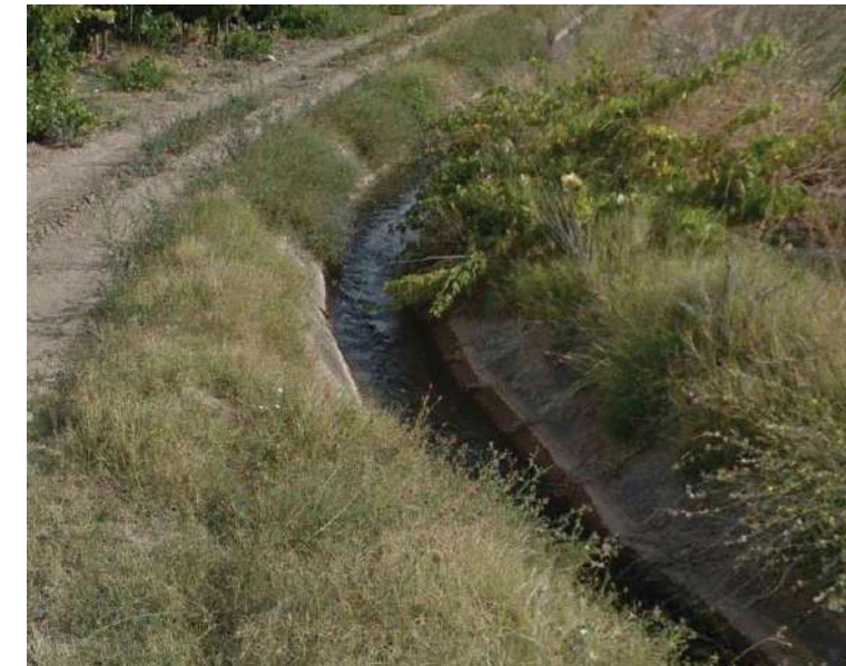
Figura 2.4: Tramo de la acequia de Bucio situado a escasos 90 metros de la zona donde se proyecta construir la balsa pie de canal y la estación de bombeo.
