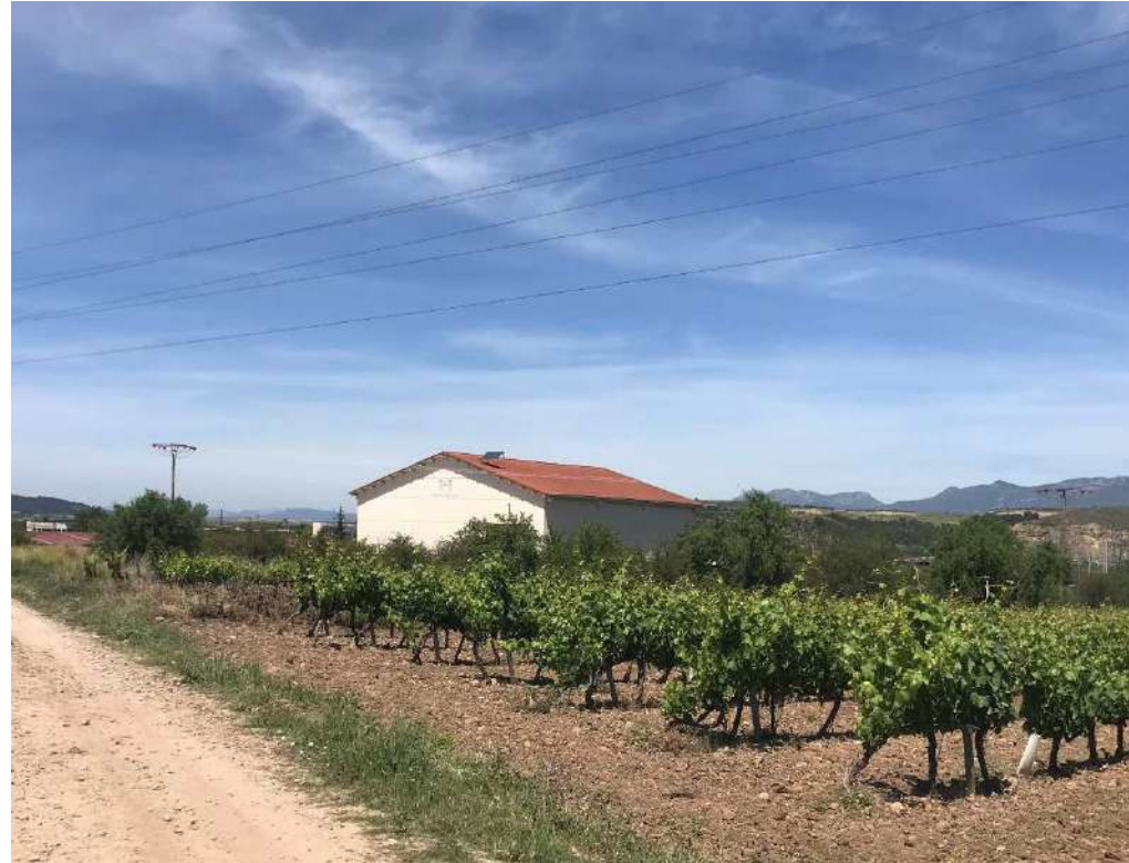
Foto 4. Construcción próxima a la balsa a pie de canal y estación de bombeo.
