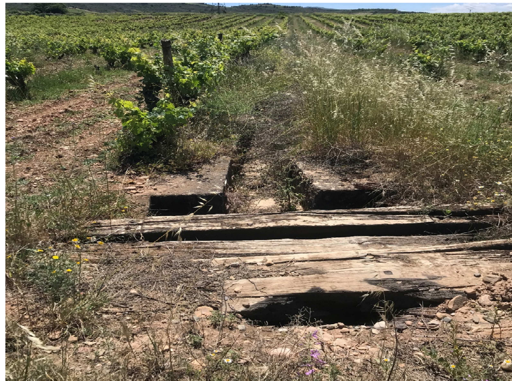
Foto 5. Acequia de hormigón. Infraestructura presente en la ubicación de la balsa a pie de canal.
