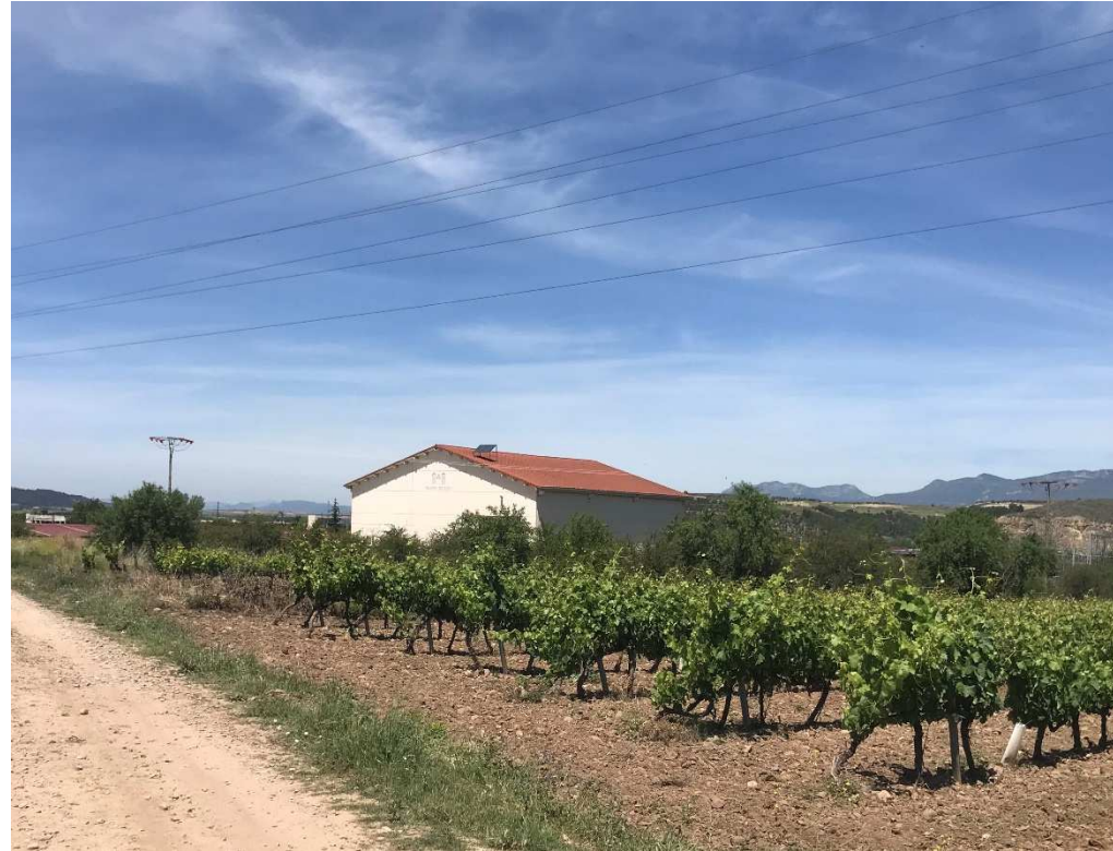
Foto 4. Construcción próxima a la balsa a pie de canal y estación de bombeo.
