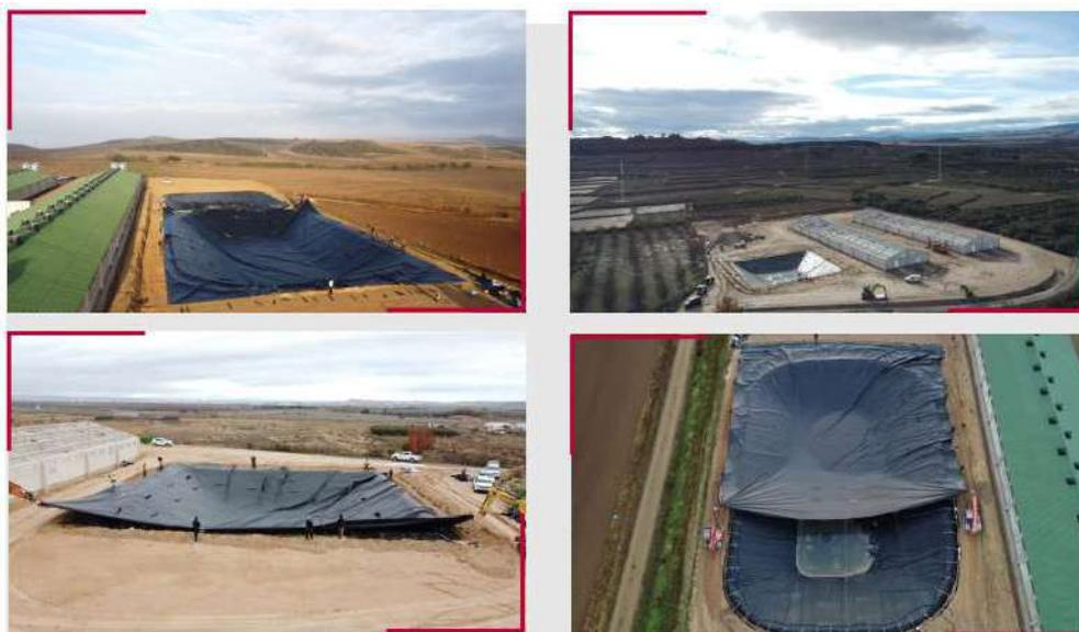
*Ejemplos reales de balsas cubiertas con lonas flotantes de polietileno flexible*
