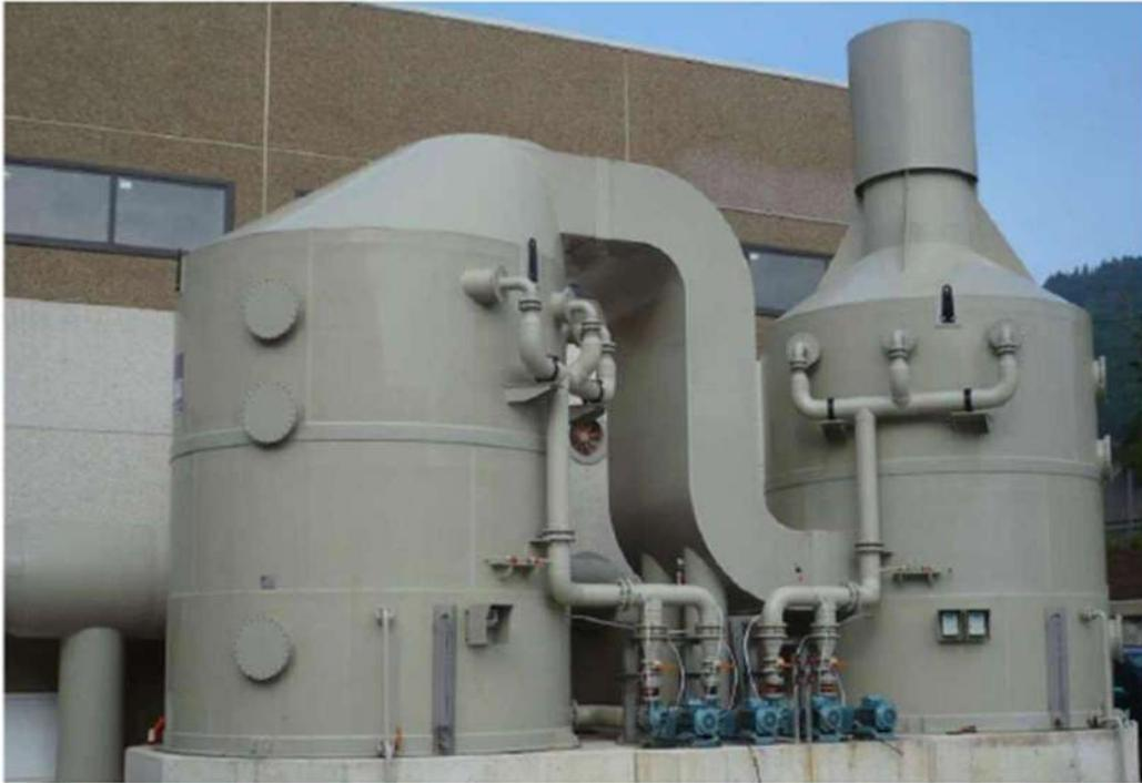
*Ejemplo de equipo de desodorización a instalar*
