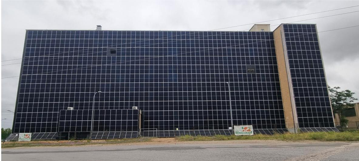
*Imagen instalación solar fotovoltaica en fachada Sur de Harinera Riojana*
