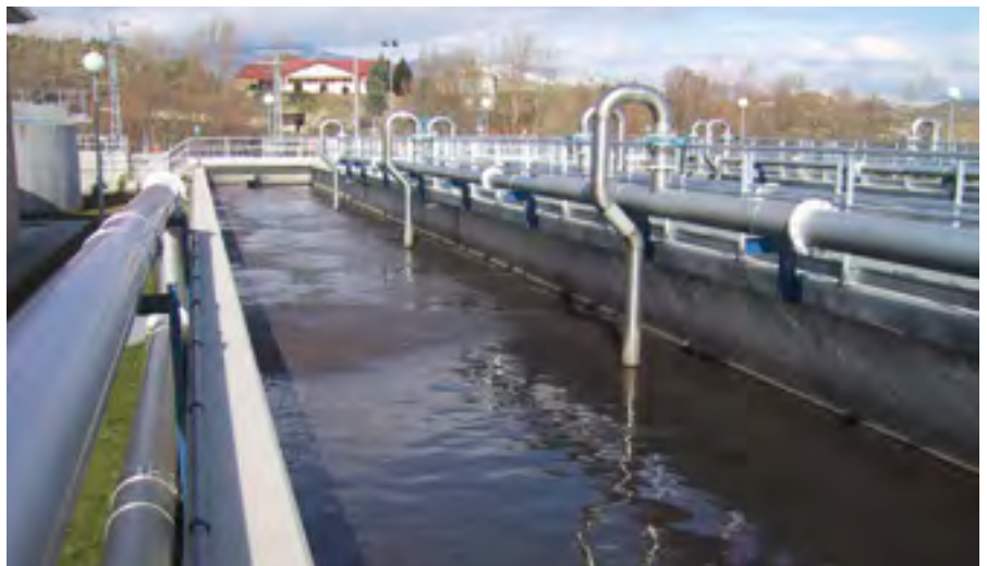
Para optimizar el funcionamiento de las EDAR se controlan también las aguas residuales de industrias ubicadas en casco urbano.
