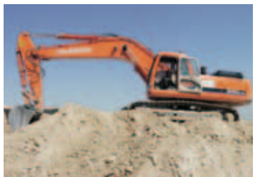
Retroexcavadora en el frente
