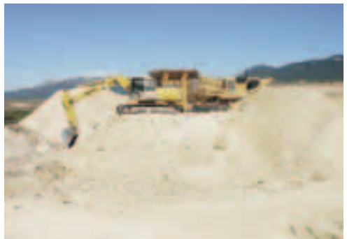
Arranque con retroexcavadora. Planta móvil
