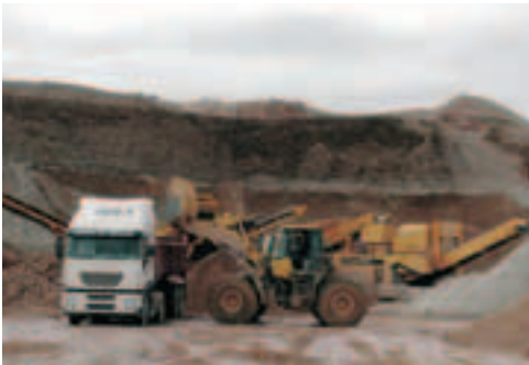
Operación de carga y transporte en la planta
