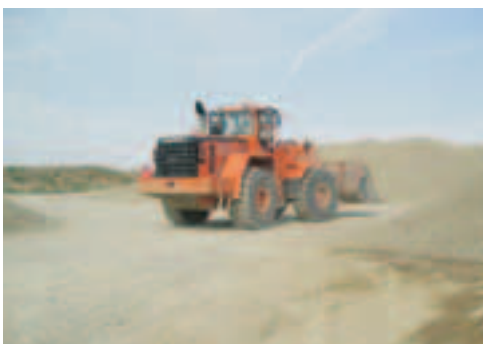
Pala cargadora cargando en acopio
