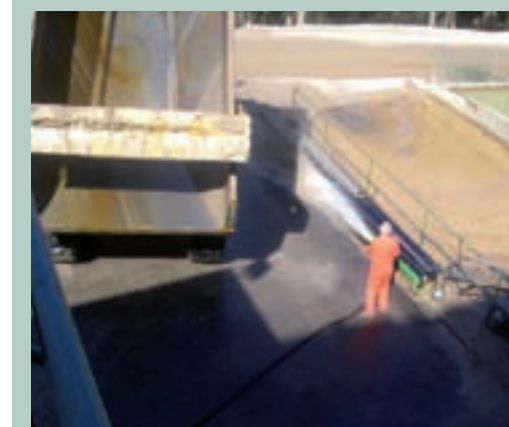
Recogida de las aguas de limpieza de los equipos móviles
