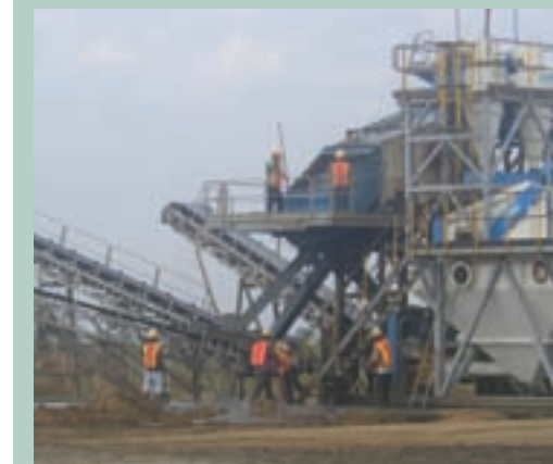
Limpieza de derrames de materiales en proceso
