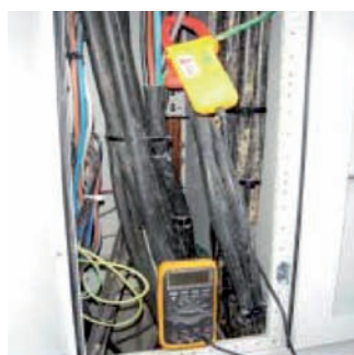
Pinzas amperimétricas conectadas a polímetro
