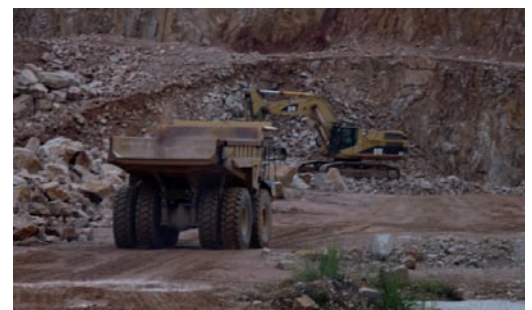
Detalle de la fase de operación
