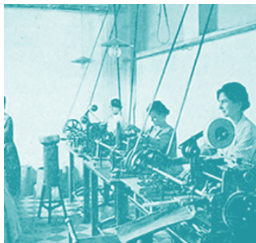
Fábrica Vda. de Solano. Interior.
