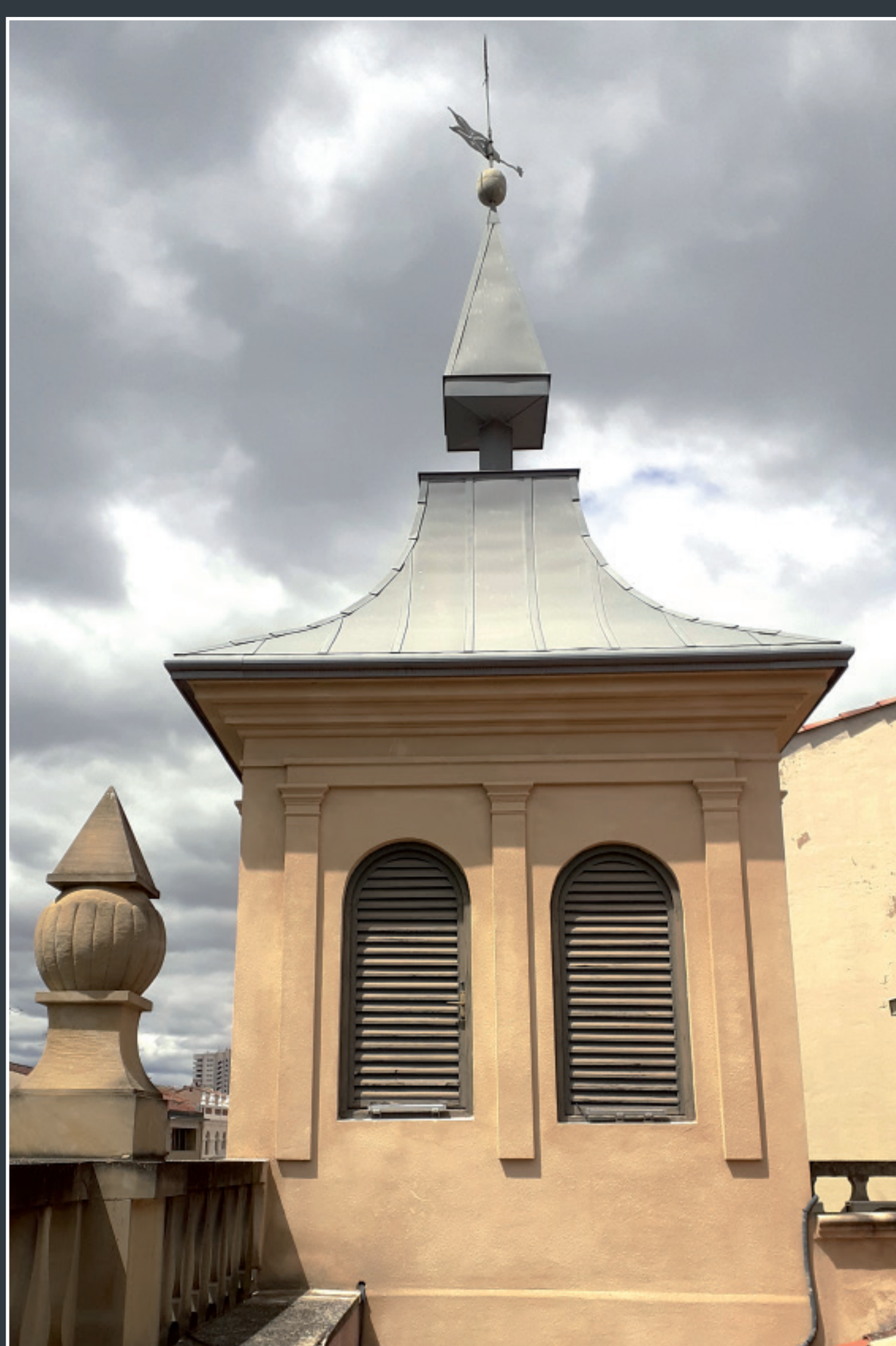
Detalle de uno de los actuales chapiteles.
