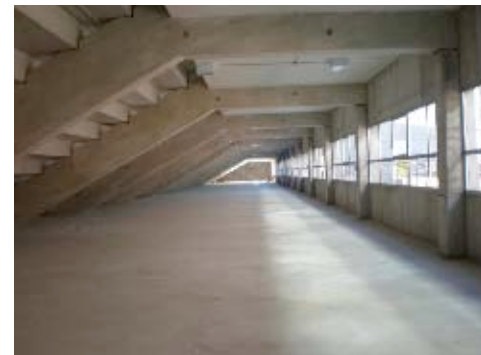
■ Espacio interior de las gradas donde se ubicarán las pistas cubiertas de atletismo
