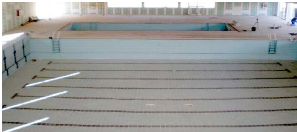
■ Piscinas del CTD Adarraga en construcción
