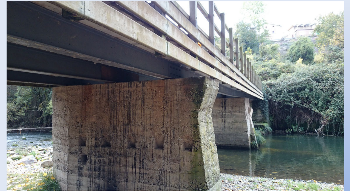
P.K. 0+150 PUENTE DE HIERRO:
