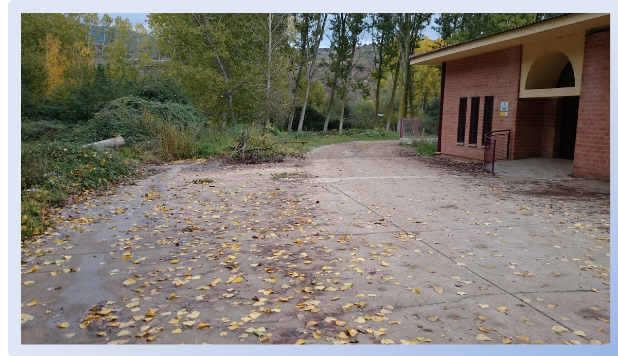
P.K. 2+080 CAMINO HORMIGONADO (ALBERGUE JUVENIL):
