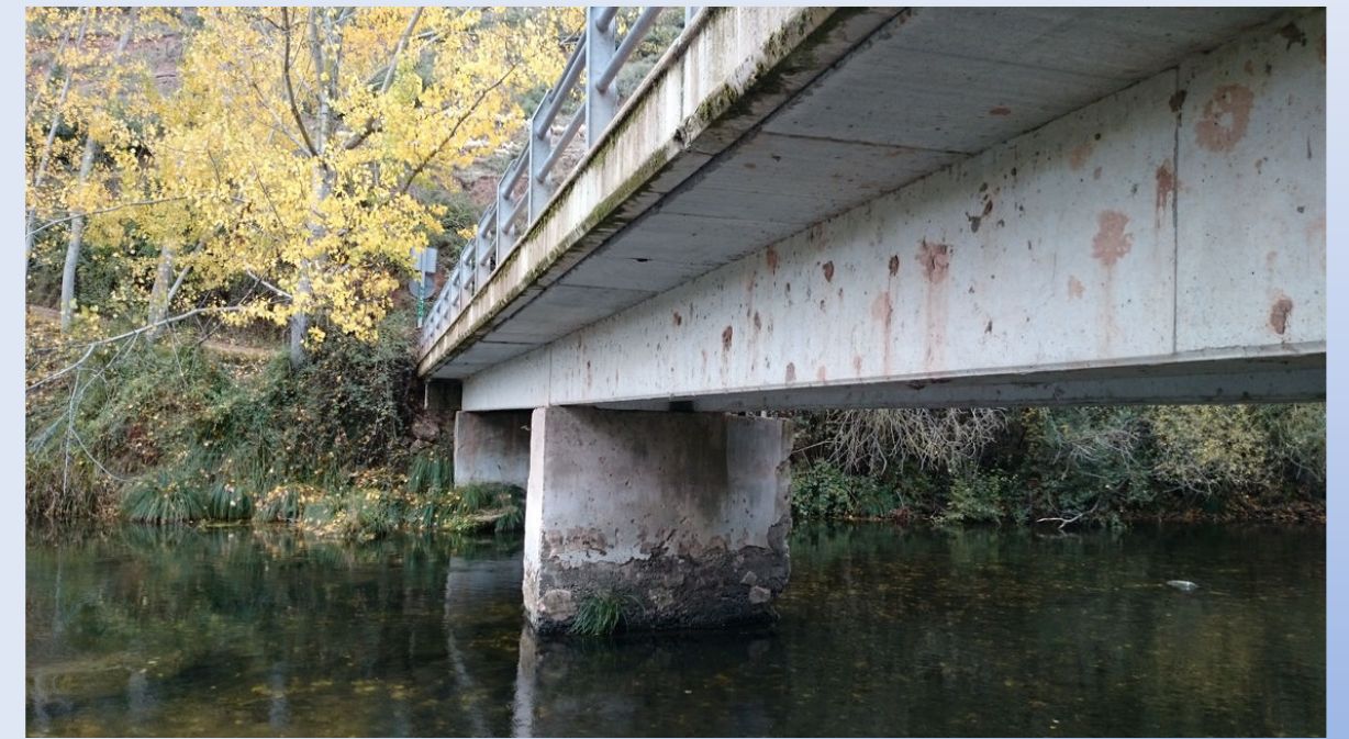
P.K. 1+950 PUENTE DE HORMIGÓN:
