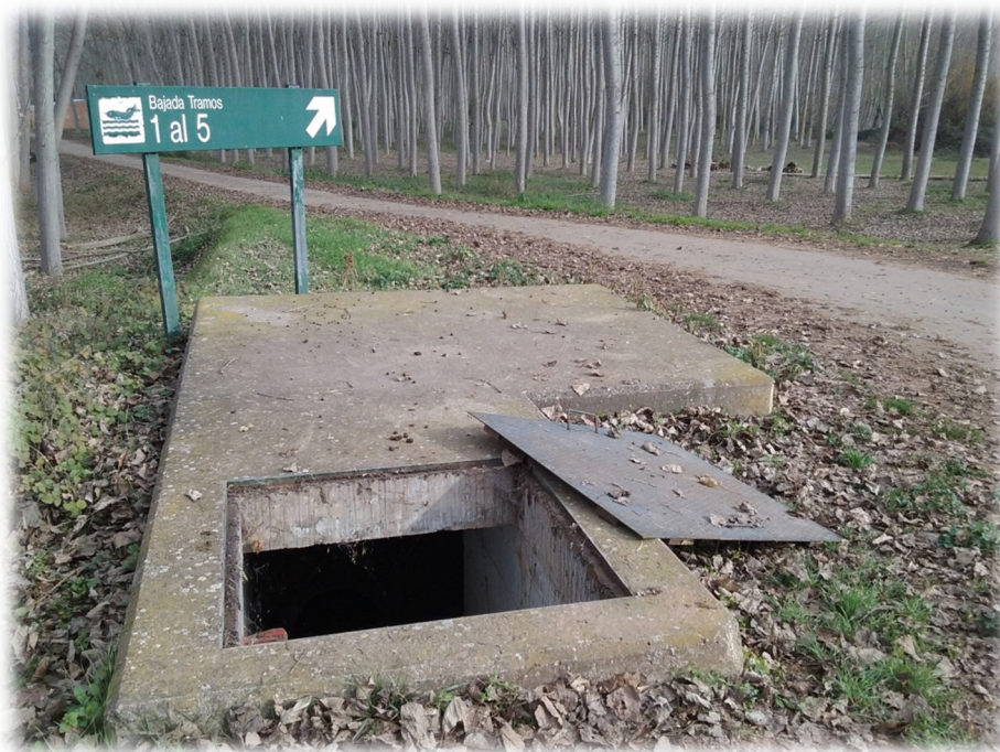
Fotografía 6: Arqueta aliviadero de llegada en Baños de Río Tobía.
