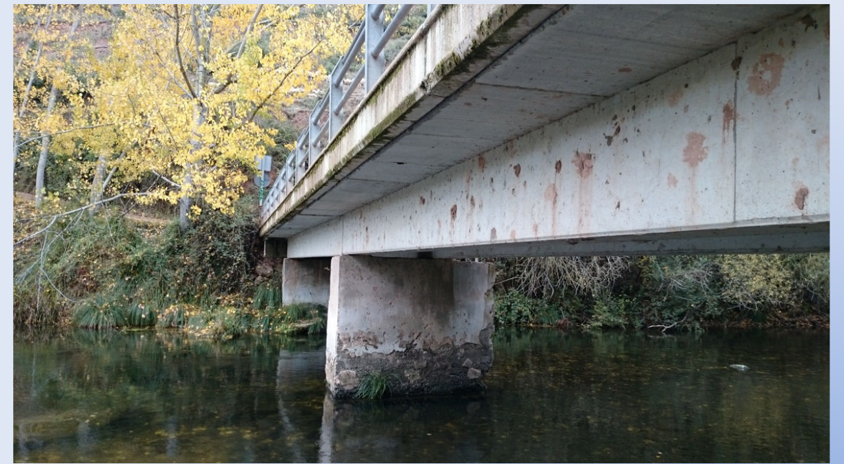
P.K. 1+610 PUENTE DE HORMIGÓN:
