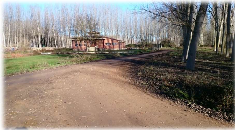
Fotografía 5: P.K. 1+800 del emisario impulsado. (Vista a P.K.+ del trazado del emisario).
