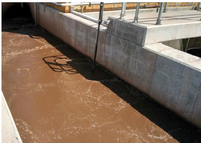
Desde el reactor el agua pasa al decantador secundario, de 6,00 m de lado y 3,00 m de profundidad en vertedero, donde se separan el agua de la materia en suspensión.
