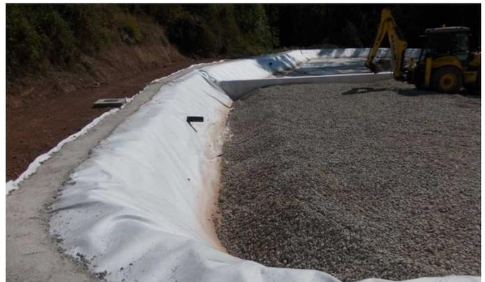
El reparto a cada celda se realiza en la zona de alimentación mediante una canaleta vertedero rodeada de grava 40/80. La recogida del efluente se realiza mediante una tubería de PVC ranurada situada en el lecho de cada vaso, dispuesta también en una zona de drenaje de grava 40/80 que finaliza en una arqueta de polipropileno.
