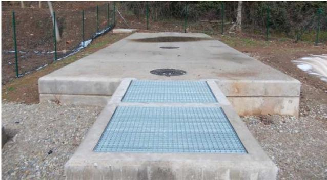
El humedal de Tobia consiste en dos vasos, con una superficie total de 1171 m<sup>2</sup>. Cada uno está impermeabilizado con una lámina impermeable de PE de 1,5 mm de espesor, y a su vez protegida interior y exteriormente por sendos geotextiles de 400 g/m<sup>2</sup>.
