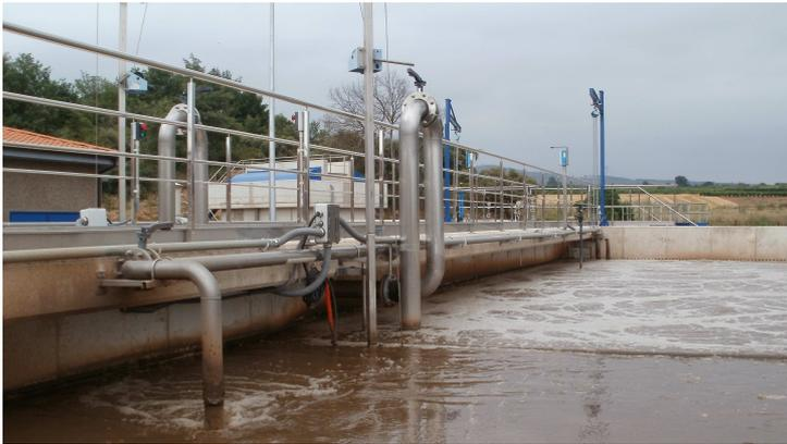
Desde los reactores el agua pasa al decantador de 15 m. de diámetro y 4,85 m. de profundidad. En él se separa el agua de la materia en suspensión, vertiéndose el agua tratada directamente al cauce receptor.
