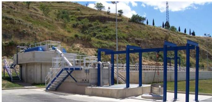
La depuradora está automatizada, de forma que se regulen todos los procesos de la misma adaptándose a las necesidades de cada momento. Así, se regula automáticamente el funcionamiento de las bombas, la aireación del reactor, la recirculación de fangos, etc..., con alarmas en todos los equipos para detectar los posibles fallos de funcionamiento.
