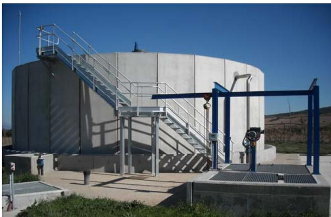
Desde el lecho, el agua pasa al decantador secundario, de 9,00 m de diámetro y 2,70 m de altura en vertedero, donde se separa el agua de la materia en suspensión.
