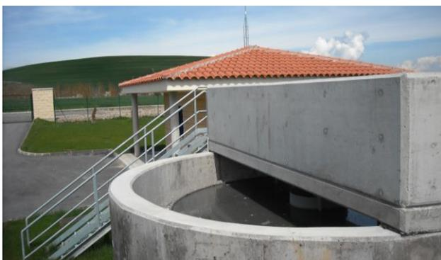
La depuradora está automatizada, de forma que los procesos se regulan para adaptar en cada momento el funcionamiento de la planta a las necesidades reales de tratamiento. Así, está regulado automáticamente el funcionamiento del tamiz, el aporte de agua al lecho y la purga y recirculación de fangos, incorporando además un sistema de alarmas para detectar los posibles fallos de funcionamiento de los equipos.
