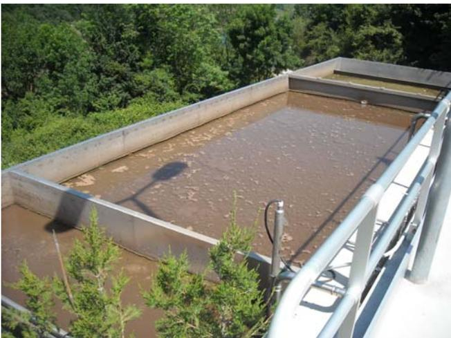
Desde el reactor el agua pasa al decantador secundario, de 4,00 m de lado y 3,00 m de profundidad en vertedero, donde se separan el agua de la materia en suspensión. En el decantador, el agua procedente del reactor biológico entra por un lateral, donde una chapa deflectora evita las alteraciones en el proceso de separación y un canal recoge el efluente clarificado.
