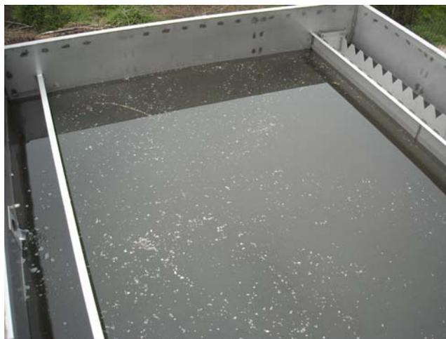
El fango procedente de la purga del decantador, dado que proviene de un proceso de aireación prolongada, está suficientemente estabilizado, requiriendo únicamente un proceso de concentración para reducir su volumen y facilitar su evacuación.
