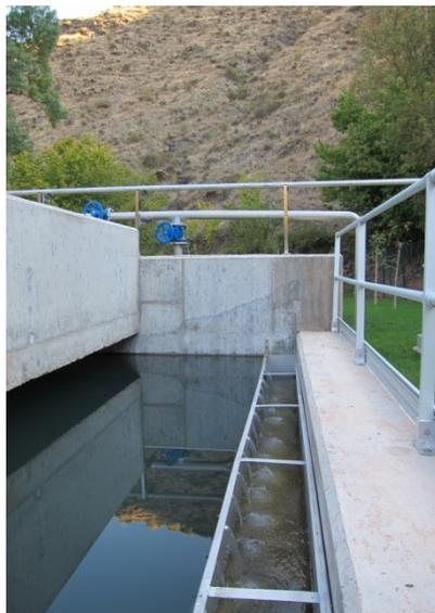
Desde el reactor el agua pasa al decantador secundario, de 6,00 m de lado y 3,75 m de profundidad en vertedero, donde se separa el agua de la materia en suspensión. El agua se incorpora al decantador a través de una campana deflectora, situada en el centro del tanque, que distribuye el flujo uniformemente hacia los dos canales perimetrales en los que se recoge el efluente clarificado.
