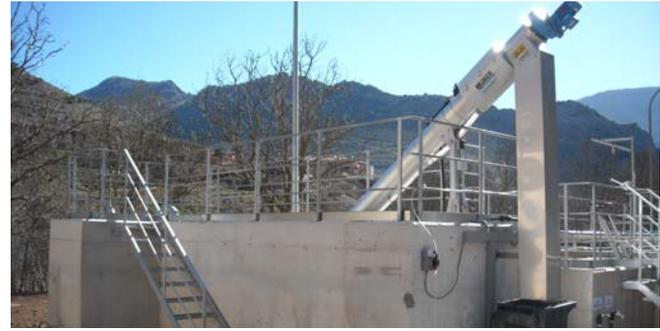
La materia retenida en el tamiz se prensa y se deposita en un contenedor para ser retirada a vertedero. Un segundo canal está equipado con una reja de limpieza manual, que funciona como by-pass del pretratamiento en caso de avería de equipo automático. Una vez retenida la fracción más gruesa el agua pasa a los reactores biológicos, de 245 m<sup>3</sup> de volumen cada uno.
