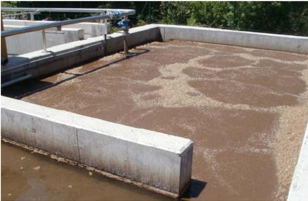
Desde el reactor el agua pasa al decantador secundario, de 6,00 m de lado y 3,75 m de profundidad en vertedero, donde se separan el agua de la materia en suspensión. El agua se incorpora al decantador a través de una campana deflectora, situada en el centro del tanque, que distribuye el flujo uniformemente hacia los dos canales perimetrales en los que se recoge el efluente clarificado.
