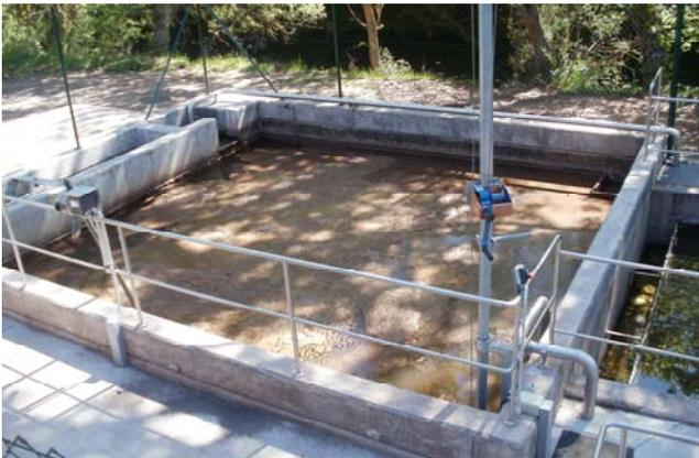
Desde el reactor el agua pasa al decantador secundario, de 4,00 m de lado y 3,15 m de profundidad en vertedero, donde se separan el agua de la materia en suspensión. En el decantador, el agua procedente del reactor biológico entra por el centro en el interior de una campana deflectora que evita las alteraciones en el proceso de separación, distribuyéndose finalmente de forma radial hacia dos canales laterales donde se recoge el efluente clarificado.
