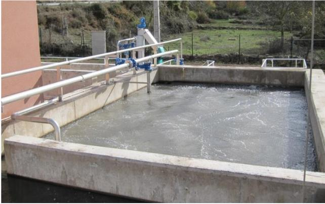
Desde el reactor el agua pasa al decantador secundario, de 5,00 m de lado y 3,50 m de profundidad en vertedero, donde se separan el agua de la materia en suspensión. El agua se incorpora al decantador a través de una campana deflectora, situada en el centro del tanque, que distribuye el flujo uniformemente hacia los dos canales perimetrales en los que se recoge el efluente clarificado.
