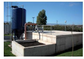
El fango procedente de la purga de los decantadores es bombeado mediante un equipo de 1,3 Kw hasta un espesador de gravedad de 2,50 m de diámetro y 4,50 m de altura en vertedero.
