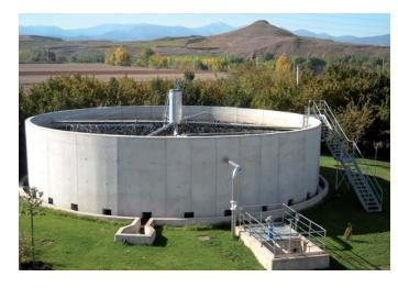
Desde el lecho, el agua pasa al decantador secundario, de 9,00 m de diámetro y 3,50 m de altura en vertedero, donde se separa el agua de la materia en suspensión.
