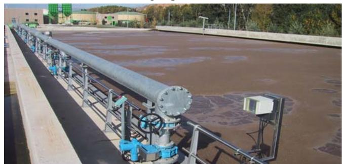
Desde el reactor, el agua se reparte a cuatro decantadores secundarios, de 48 m. de diámetro y 3,60 m. de profundidad, donde se separa el agua de la materia en suspensión. El agua ya tratada se vierte al río. Una parte de la materia en suspensión retenida en el decantador se recircula al reactor para mantener una concentración elevada de microorganismos y asegurar así la depuración del agua. El resto se extrae del sistema para mantener constantes las condiciones de funcionamiento.
