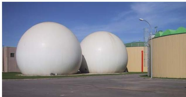
Desde los gasómetros se alimentan dos motogeneradores de 477 Kw de potencia eléctrica máxima cada uno de ellos, en los que se genera un 55 % de la energía consumida en la instalación. Se encuentran equipados con un sistema de recuperación de calor en el circuito de refrigeración del motor y en los gases de escape, para calentamiento de los fangos en los digestores.
