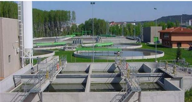
En una segunda fase del proceso, mediante la concurrencia de microorganismos (proceso biológico), la materia orgánica presente en el agua es transformada en materia en suspensión, de forma que pueda ser retenida por decantación.
