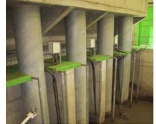
En primer lugar se retiran los sólidos de mayor tamaño que transporta el agua haciéndola pasar a través de tres rejillas automáticas de 50 mm de paso y, a continuación, por tres tamices de 3 mm de luz montados en sendos canales paralelos. Los sólidos retenidos en esta etapa se recogen en un tornillo transportador que los compacta y los deposita en contenedores para ser eliminados en vertedero.
