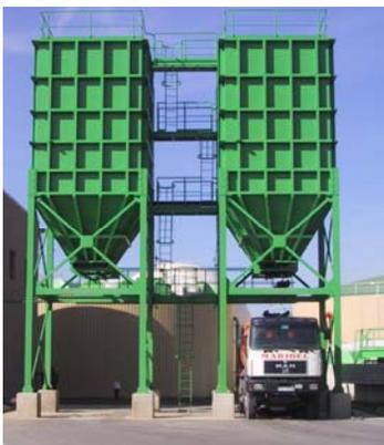
El fango deshidratado se almacena en dos silos, con una capacidad total de 220 m<sup>3</sup>, a los que les llega el fango impulsado desde la salida de las centrifugas mediante dos bombas de tornillo.
