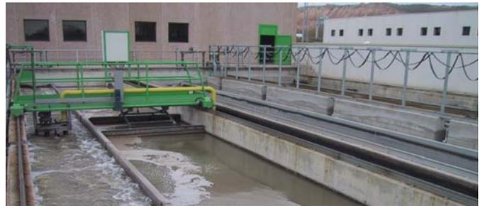
La planta dispone de una instalación de tratamiento físico-químico compuesta por cámara de mezcla, de floculación y la instalación para dosificación de reactivos. Su objetivo es reforzar el tratamiento ante vertidos industriales estando habitualmente fuera de servicio.
