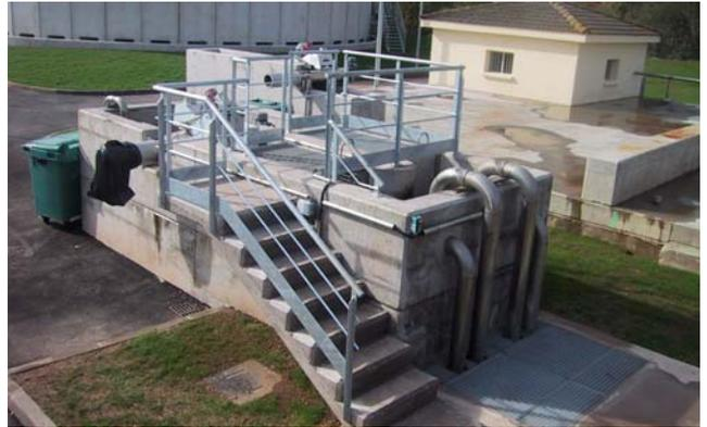
Eliminada la fracción más gruesa, el agua pasa al decantador primario, de 9 m de diámetro y 3 m de profundidad, donde se elimina, por acción de la gravedad, aproximadamente un 75% de la materia en suspensión y un 40 % del total de materia orgánica.
