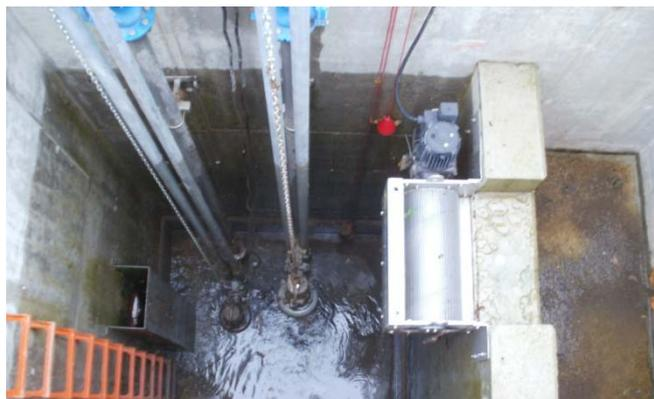
El pretratamiento está integrado por dos canales, uno de ellos equipado con un tamiz automático de 3 mm de paso y el otro que funciona en caso de emergencia como by-pass del primero, con una reja de limpieza manual. La materia retenida en el tamiz se prensa y se deposita en un contenedor para ser retirada a vertedero y el agua pasa al reactor biológico.
