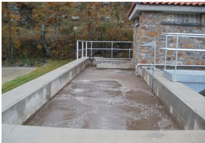
Desde el reactor el agua pasa al decantador secundario, de 7,00 m de lado y 4,32 m de profundidad en vertedero, donde se separan el agua de la materia en suspensión.
