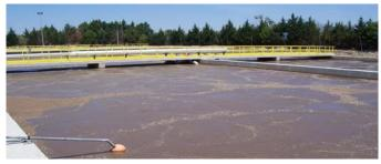
Desde los reactores el agua se reparte a dos decantadores secundarios, de 19 m de diámetro y 4 m de profundidad en vertedero, donde se separa el agua de la materia en suspensión.
