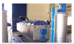
En primer lugar el fango purgado del decantador se envía a dos espesadores mecánicos de tambor con tela filtrante, de 75 m³/h cada uno, donde se concentra con la ayuda de un coagulante.
