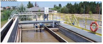
Posteriormente el agua residual se incorpora a la segunda fase del proceso donde, mediante la concurrencia de microorganismos (proceso biológico), la materia orgánica presente en el agua se transforma en materia en suspensión que puede ser separada por decantación. Este proceso se desarrolla en el reactor biológico, dos cubas de 10.440 m³ en total, aireadas mediante difusores de burbuja fina.
