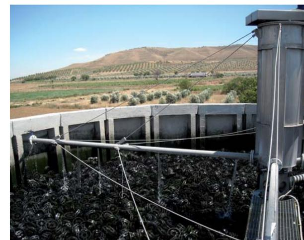
Desde el lecho, el agua pasa al decantador secundario, de planta cuadrada de 5,50 m de lado y 4,00 m de profundidad, donde se separa el agua de la materia en suspensión.
