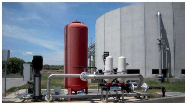
La depuradora está automatizada, de forma que los procesos se regulan para adaptar en cada momento el funcionamiento de la planta a las necesidades reales de tratamiento. Así, está regulado automáticamente el funcionamiento del tamiz, el aporte de agua al lecho y la purga y recirculación de fangos, incorporando además un sistema de alarmas para detectar los posibles fallos de funcionamiento de los equipos.
