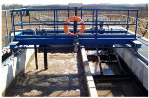
La depuradora está automatizada, de forma que los procesos se regulan para adaptar en cada momento el funcionamiento de la planta a las necesidades reales de tratamiento. Está regulado automáticamente el funcionamiento de las bombas, la aireación del reactor, la recirculación de fangos etc..., incorporando además un sistema de alarmas para detectar los posibles fallos de funcionamiento de los equipos.
