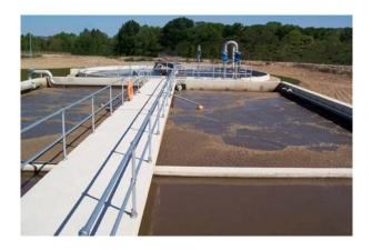
Desde el reactor el agua pasa al decantador secundario, de 23 m de diámetro y 3,53 m de profundidad en vertedero, donde se separa el agua de la materia en suspensión.
