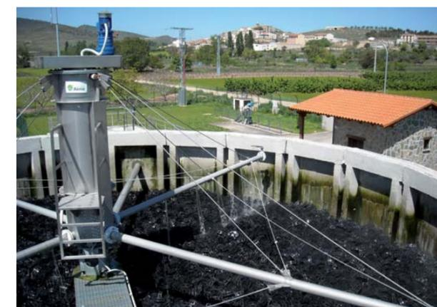
Desde el lecho, el agua pasa al decantador secundario, de planta cuadrada de 5,50 m de lado y 4,00 m de profundidad, donde se separa el agua de la materia en suspensión.
